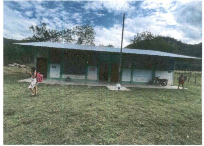
Foto 2: Finalización del techado de la escuela.
