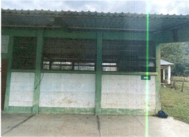
Foto 3: Mantenimiento de ventanas finalizada
