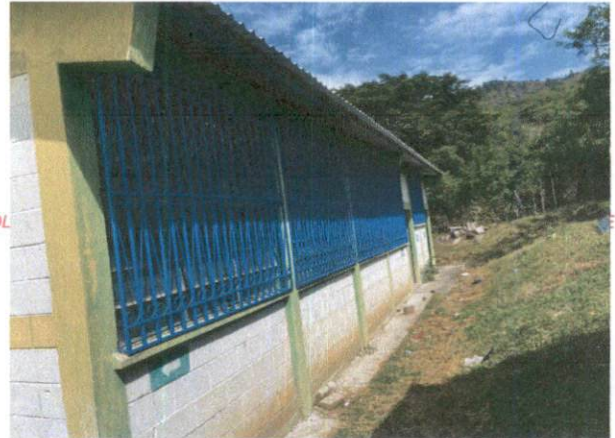
Foto 4: Instalación de balcones finalizada
